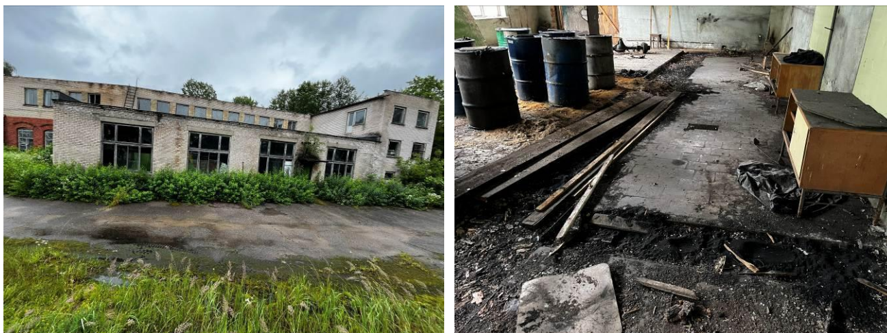
3 pav. Pastatas su latakais grindyse ir NP talpomis.
