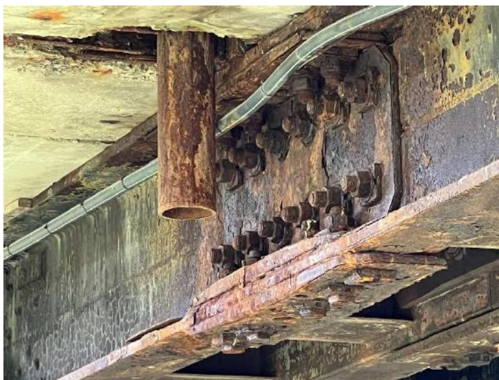
8 pav. Vandens nuleidimo įrenginiai yra per trumpi, koroduoja.
