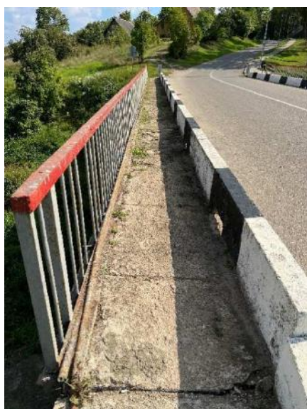
5 pav. Šalitelčių betonas aptrupėjęs, kaupiasi gruntas, apaugę žolėmis. Šalitelčiai neturi vandens nubėgimo, sėda prietilčiai.
