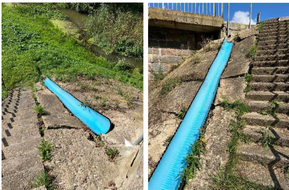
15 pav. Nulaužtas vandens nubėgimo vamzdis, vanduo bėga ant sutvirtinimų, apaugę, sutrūkęs betonas.
