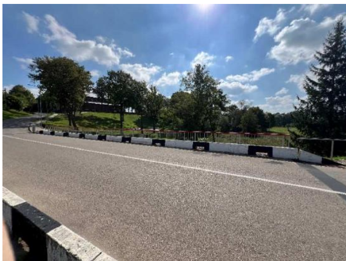
4 pav. Atitvarai yra per žemi.
