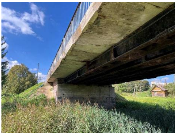
9 pav. Po šalitimais plokščių betonas aptrupėjęs, vietomis matosi atvira koroduojanti armatūra.
