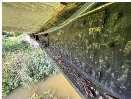
9 pav. Po šalitimais plokščių betonas aptrupėjęs, vietomis matosi atvira koroduojanti armatūra.
