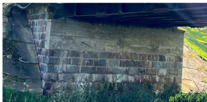
11 pav. Iš ramtų akmenų mūro siūlių ištrupėjusi rišamoji medžiaga, įtrūkimai mūro siūlėse, sunkiasi vanduo.
