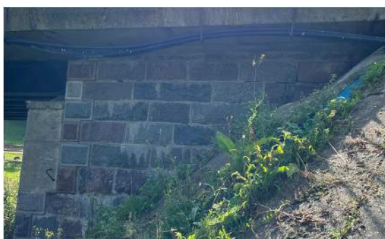
11 pav. Iš ramtų akmenų mūro siūlių ištrupėjusi rišamoji medžiaga, įtrūkimai mūro siūlėse, sunkiasi vanduo.
