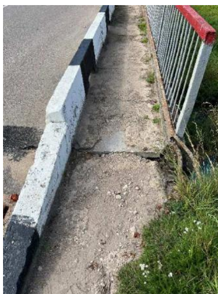
5 pav. Šalitelčių betonas aptrupėjęs, kaupiasi gruntas, apaugę žolėmis. Šalitelčiai neturi vandens nubėgimo, sėda prietilčiai.
