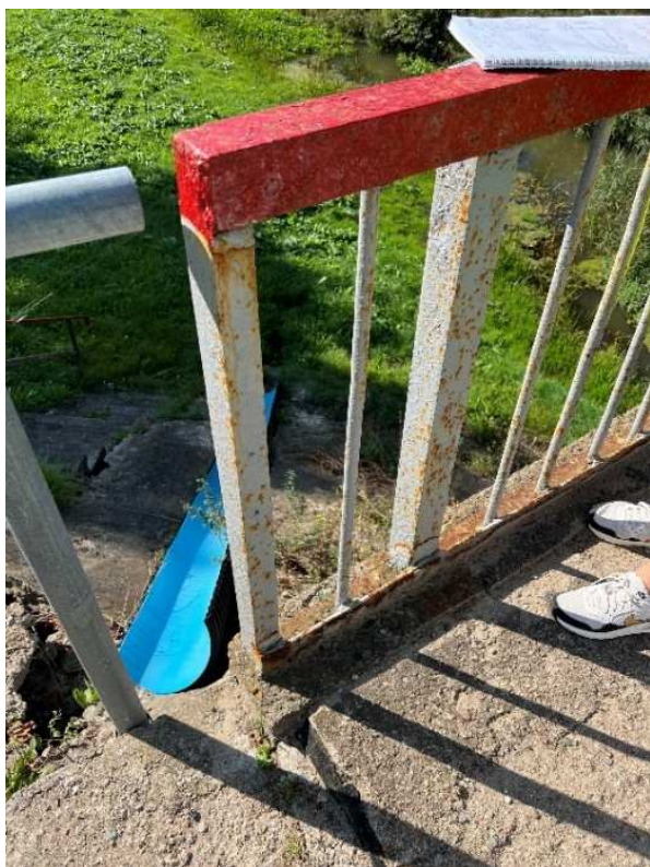
6 pav. Nusidėvėjusi turėklų apsauginė danga, pažeisti korozijos. Turėklai pasvirę į upės pusę ir aptrupėję turėkliniai bortai.
