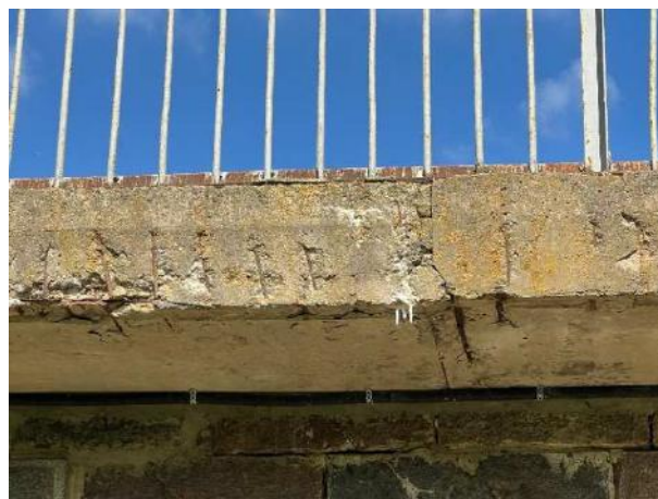
9 pav. Po šalitimais plokščių betonas aptrupėjęs, vietomis matosi atvira koroduojanti armatūra.
