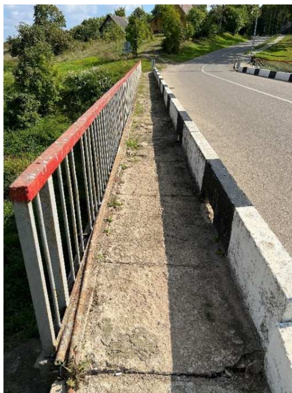
6 pav. Nusidėvėjusi turėklų apsauginė danga, pažeisti korozijos. Turėklai pasvirę į upės pusę ir aptrupėję turėkliniai bortai.
