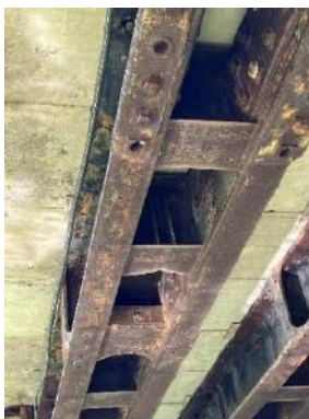
9 pav. Po šalitimais plokščių betonas aptrupėjęs, vietomis matosi atvira koroduojanti armatūra.
