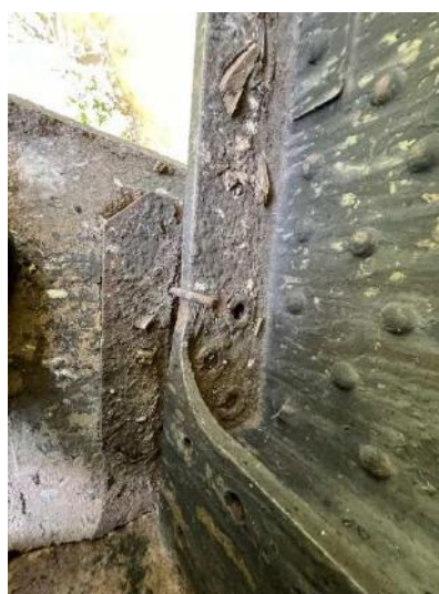
12 pav. Atraminiai guoliai koroduoja.
