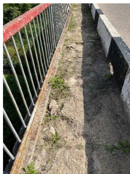
5 pav. Šalitelčių betonas aptrupėjęs, kaupiasi gruntas, apaugę žolėmis. Šalitelčiai neturi vandens nubėgimo, sėda prietilčiai.
