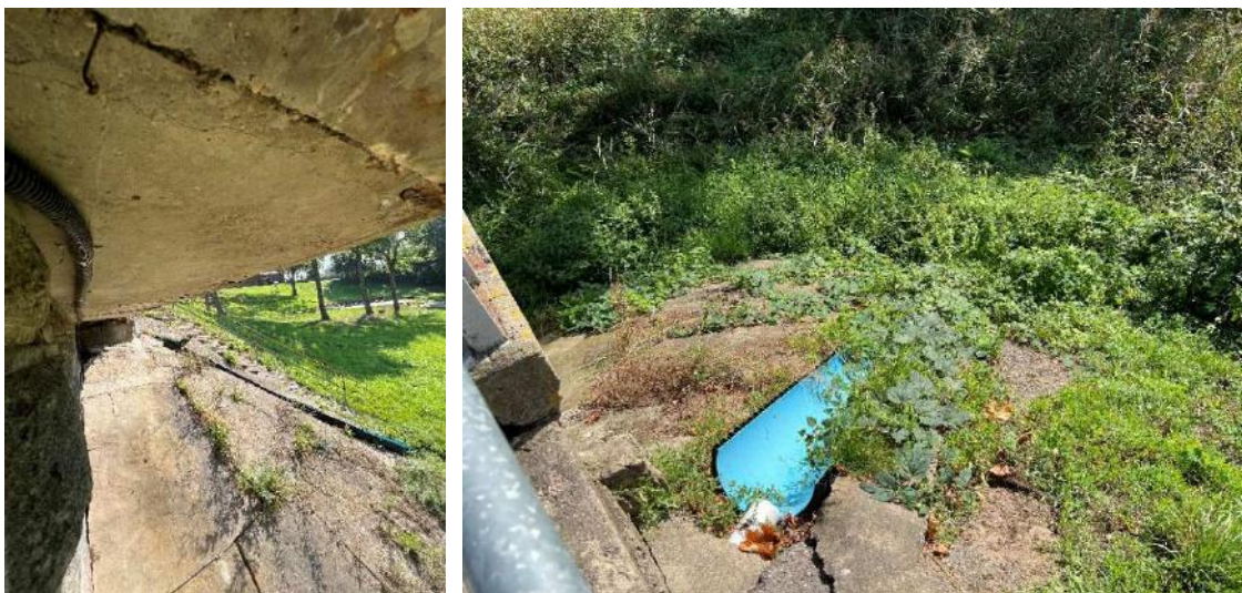
15 pav. Nulaužtas vandens nubėgimo vamzdis, vanduo bėga ant sutvirtinimų, apaugę, sutrūkęs betonas.
