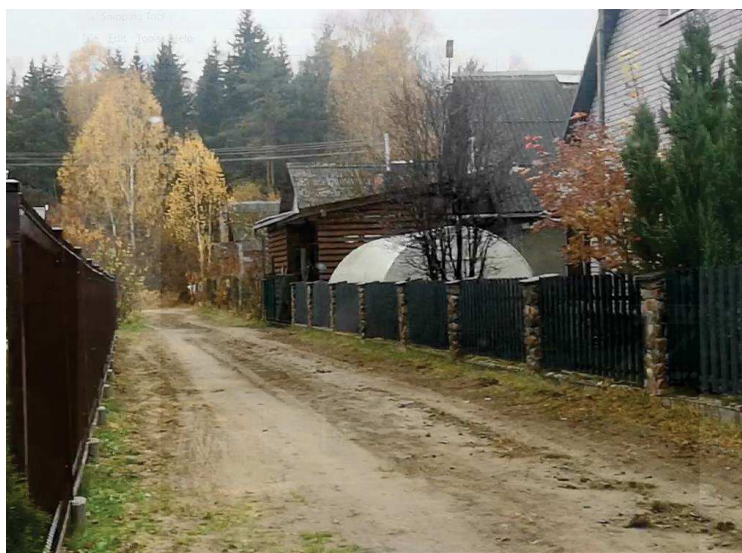
Pav. 8. Gatvės Nr. GTV-P58 techninė būklė
