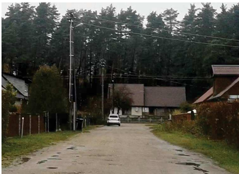
Pav. 4. Vilniaus g. kvartalinės gatvės Nr. 2 techninė būklė
