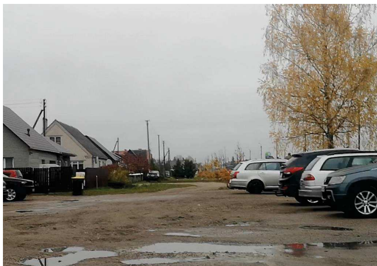
Pav. 7. Vilniaus g. jungiamosios gatvės aikštelės techninė būklė
