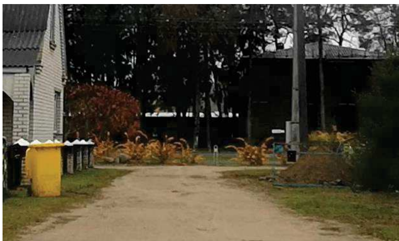
Pav. 5. Vilniaus g. kvartalinės gatvės Nr. 3 techninė būklė
