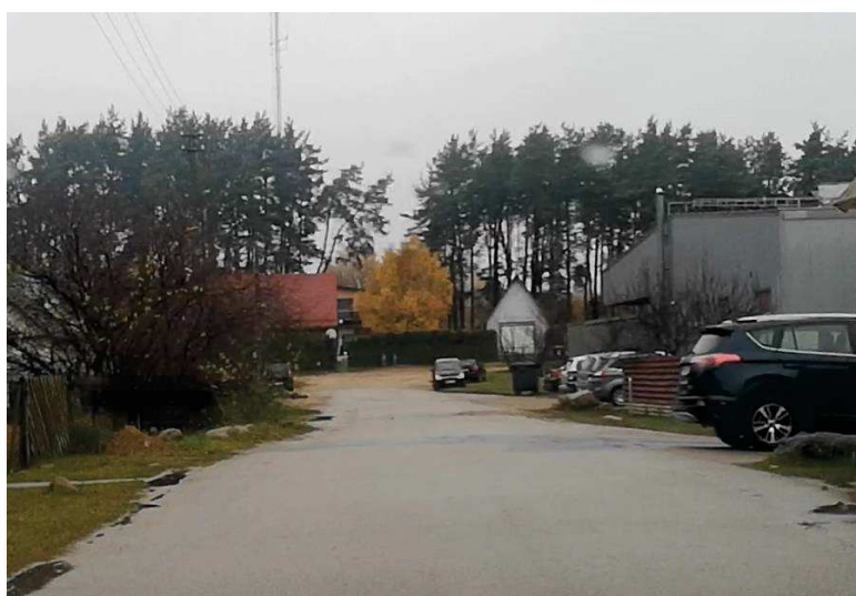
Pav. 9. Gatvės Nr. GTV-P57 techninė būklė
