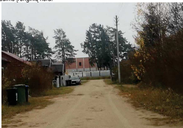
Pav. 3. Vilniaus g. kvartalinės gatvės Nr. 1 techninė būklė
