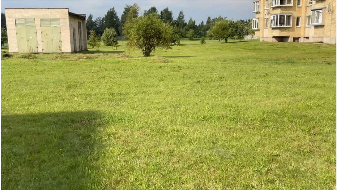
Pav. 4. Kvartalinės gatvės Nr. 1 techninė būklė
