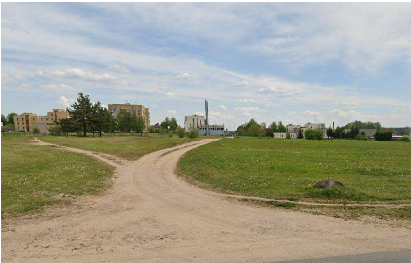
Pav. 2. Žaliosios gatvės techninė būklė
