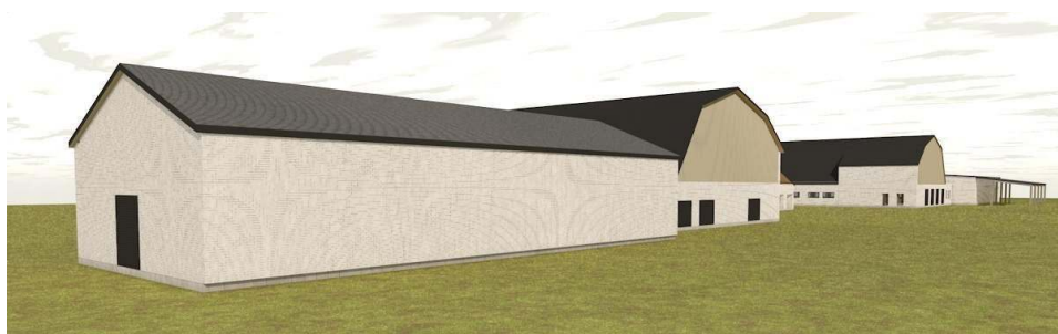
Pastatų Nr.1, Nr. 2 ir Nr.3 vaizdas iš pietvakarių pusės po nugriovimo dviejų aukštų korpuso
