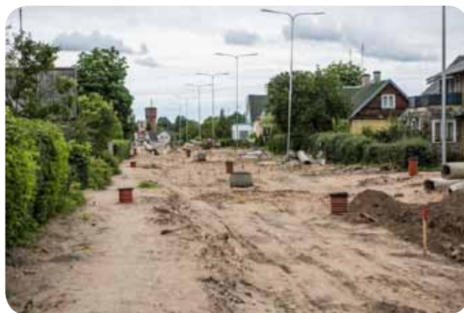
Kaltanėnų g. Švenčionėliuose po ilgų statybų taps viena moderniausių rajono gatvių
